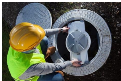
Figuur 1 Putdeksel met antenne
